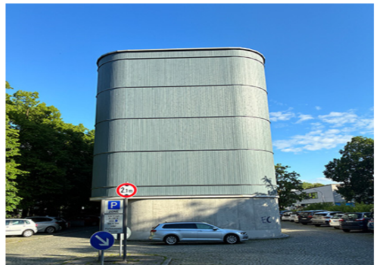
Fig. 13. Wohnen am Dantebad, North-facing facade, 2026
