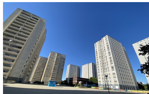
Fig. 4. Cité du Chemin Vert: Grands Ensemble in Bobigny (2022)
