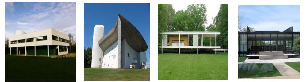
Villa Savoye, Le Corbusier la chapelle de ronchamp, Le Corbusier Farnsworth House, Mies van Rohe IIT Crown Hall, Mies van Rohe
