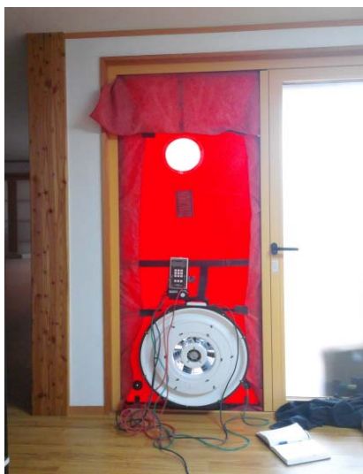
Fig. 8. Blower Door Test
