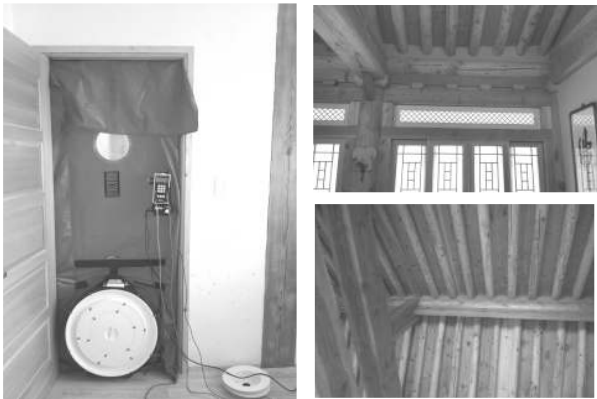
a) 블로어 도어 설치 b) 거실 천장 사레
