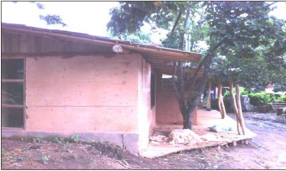
그림 12. 흙벽과 대나무 지붕 시공
