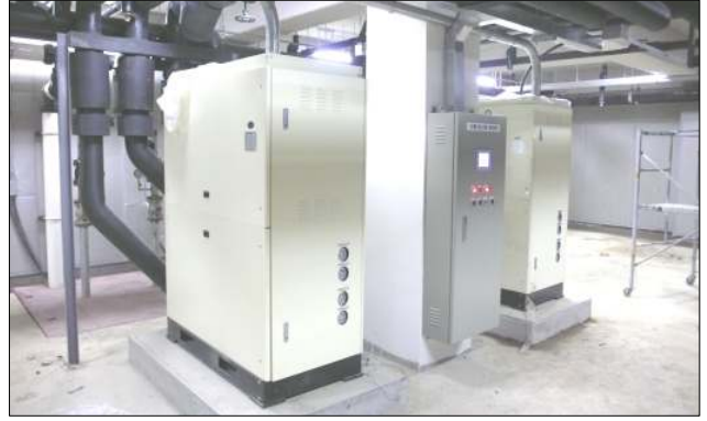
그림 5. 지열 냉·난방 시스템
