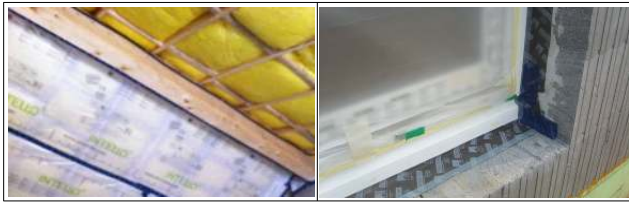
a. 지붕 기밀작업 b. 벽-프레임 그림 3-8. ALT-4 기밀 시공사진
