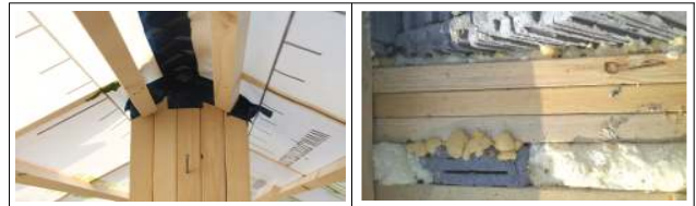
a. 기둥 부위 기밀작업 b. 벽-지붕연결부작업 그림 3-6. ALT-3 기밀 시공사진
